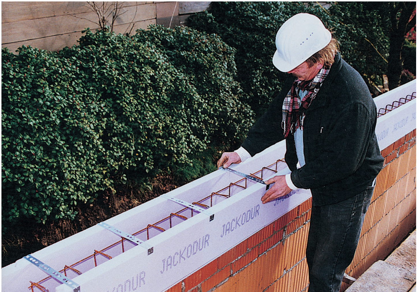
Foto: Ringbalk resp. ringanker met JDS isolatierandbekisting
