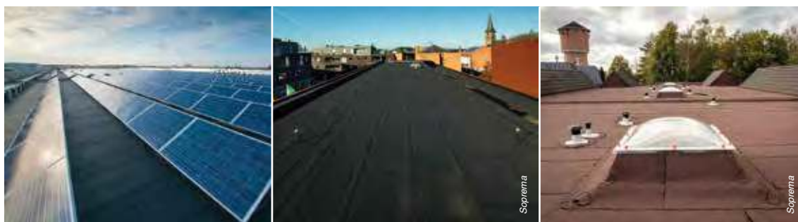
Afbeelding 7, 8 en 9: Bitumineus dichtingssysteem
