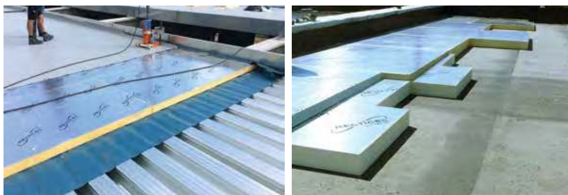
Afbeelding 1: Dampremmende laag (links: PE-folie; rechts: bitumineuze dampremmende laag)
