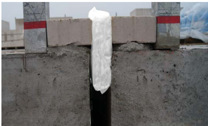
De AIRTIGHT® Air Stop als luchtdichte afsluiting tussen de woningscheidende wand.
