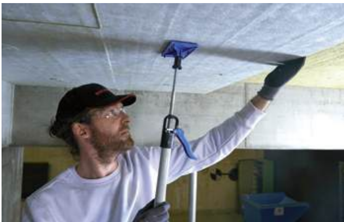
Stap 1: uitstekende brandveiligheid met Conlit Steelprotect Board
